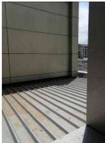
Şekil 2 : 3 no.lu daire cephe görüntüsü
